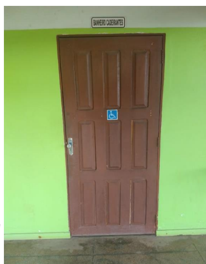
Figura 07 – porta de banheiro para cadeirantes ABNT 9050/2015 / porta de banheiro para cadeirantes CERNDR
